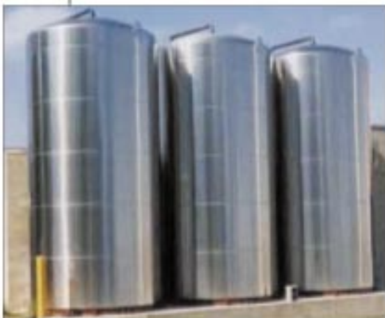
Tanques de almacenamiento tipo silo de 12.000 galones—cubierta exterior de acero inoxidable.
